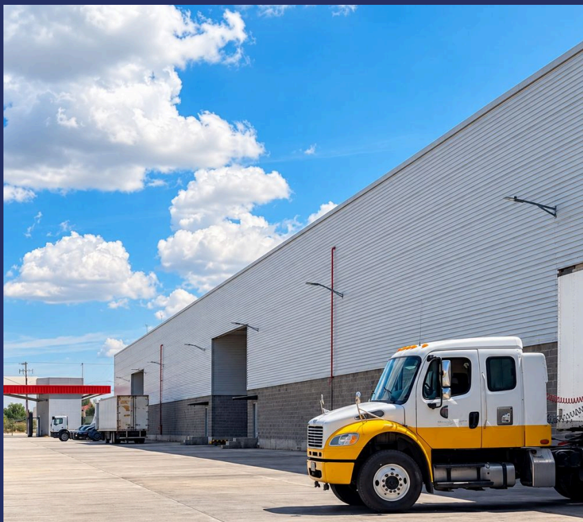
05.1 Exterior. Acceso, andén y patio de maniobras de la bodega.
