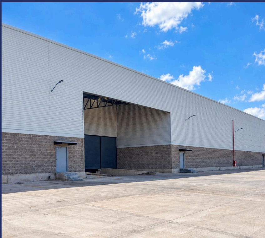
07.1 Exterior. Acceso, andén y patio de maniobras de la bodega.
