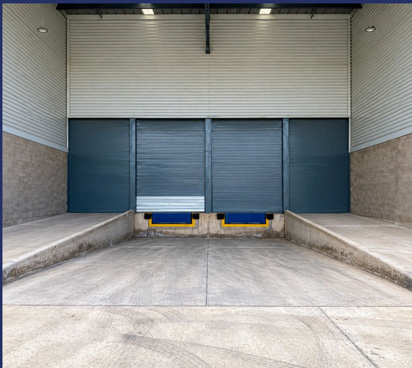
10.1 Exterior. Acceso, andén y patio de maniobras de la bodega.
