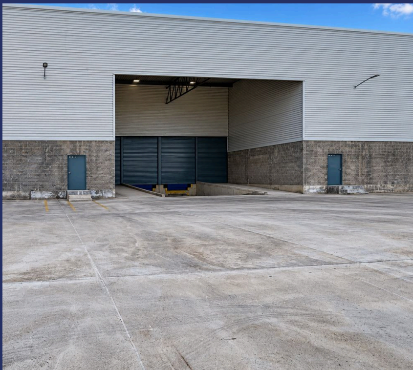
15.1 Exterior. Acceso, andén y patio de maniobras de la bodega.
