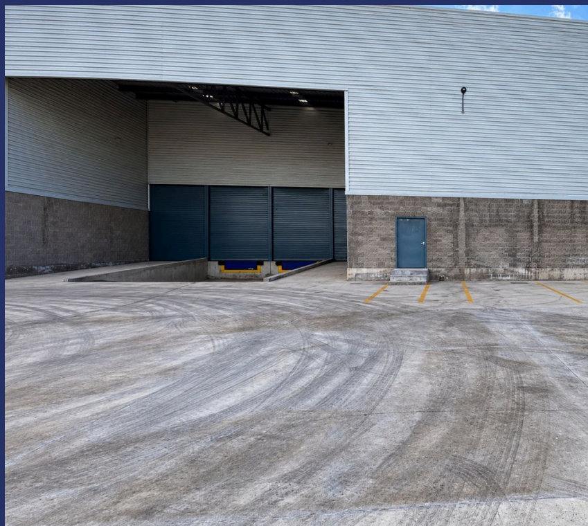
11.1 Exterior. Acceso, andén y patio de maniobras de la bodega.
