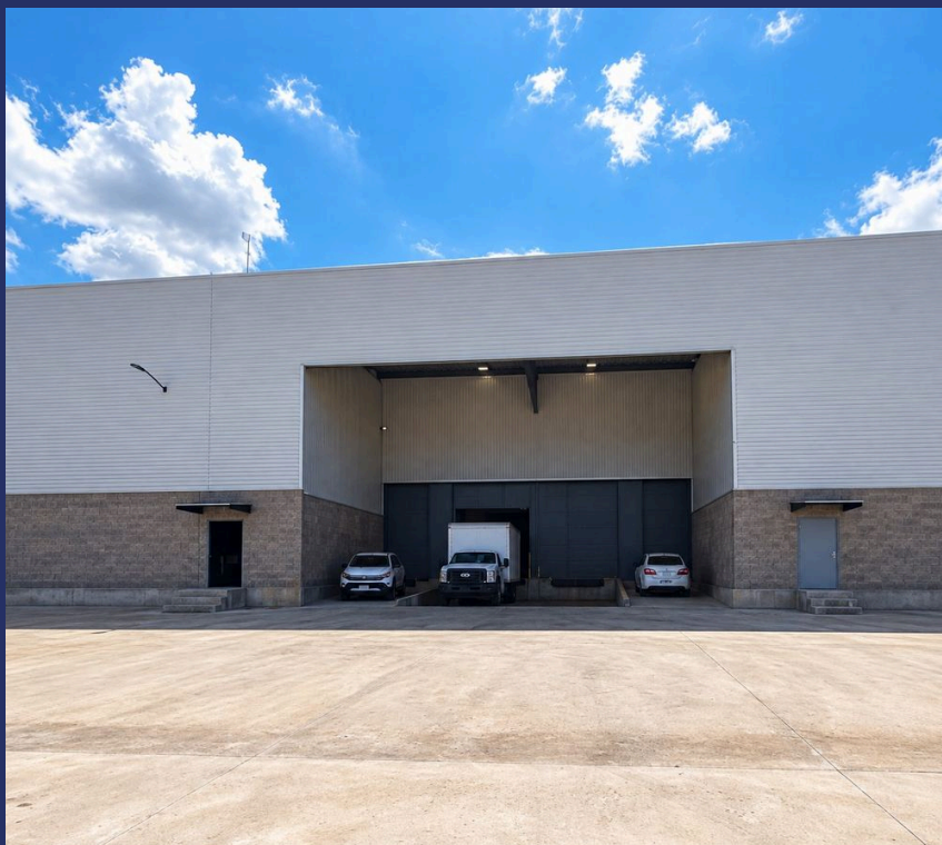
08.1 Exterior. Acceso, andén y patio de maniobras de la bodega.
