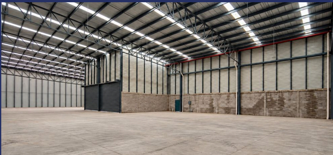
10.2 Interior. Nave libre con estructura metálica, muro de block y lámina.
