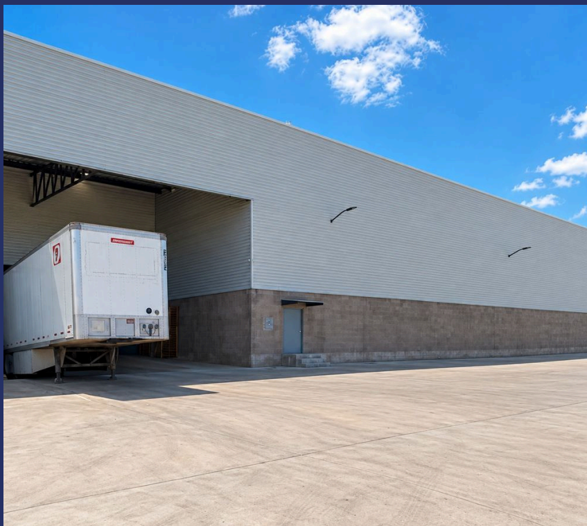
09.1 Exterior. Acceso, andén y patio de maniobras de la bodega.
