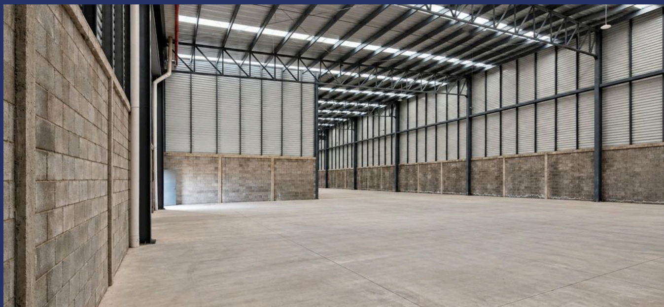
11.2 Interior. Nave libre con estructura metálica, muro de block y lámina.
