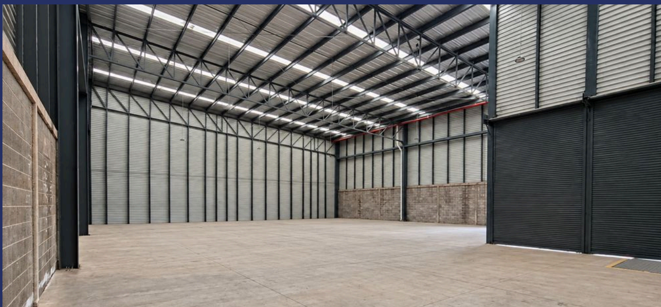
09.2 Interior. Nave libre con estructura metálica, muro de block y lámina.
