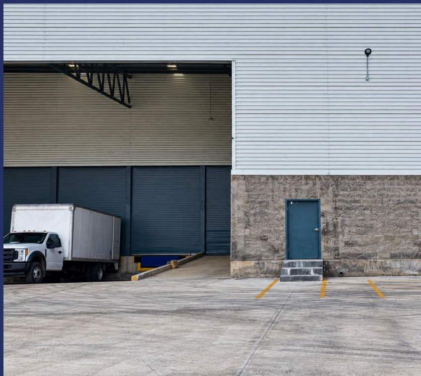
14.1 Exterior. Acceso, andén y patio de maniobras de la bodega.
