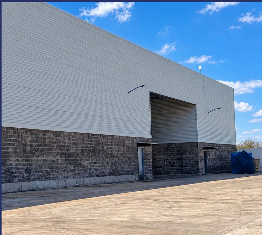
17.1 Exterior. Acceso, andén y patio de maniobras de la bodega.
