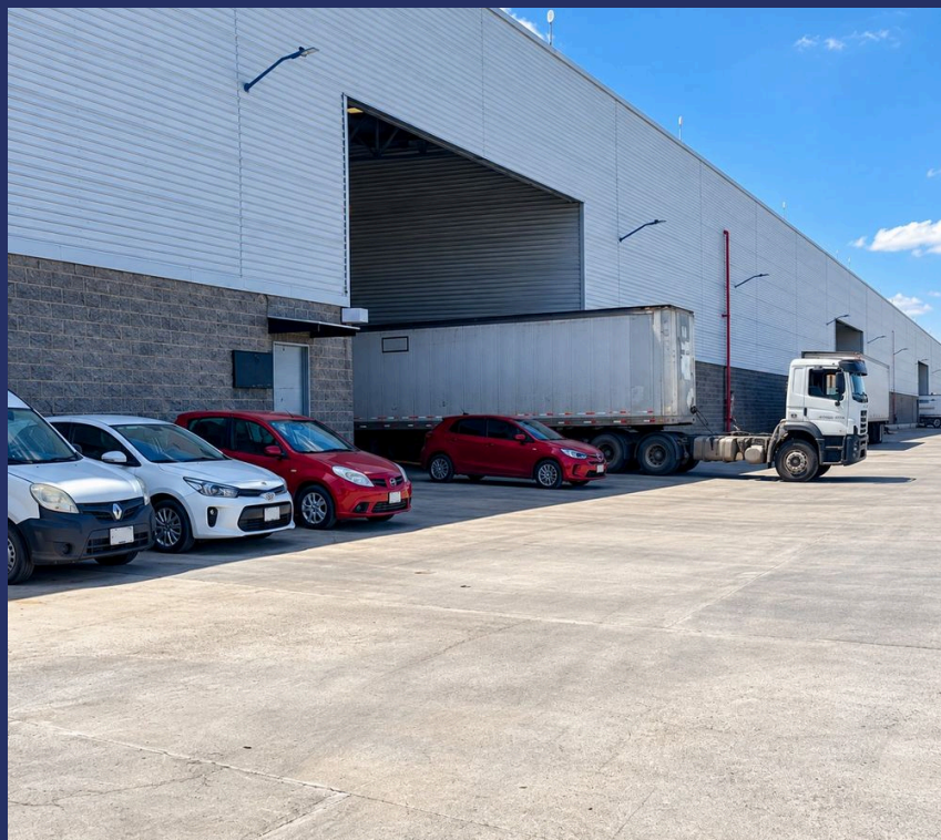
04.1 Exterior. Acceso, andén y patio de maniobras de la bodega.
