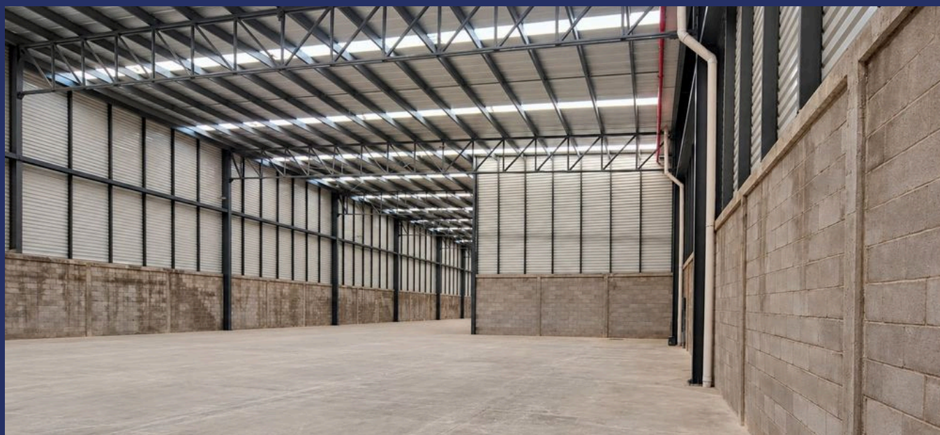
14.2 Interior. Nave libre con estructura metálica, muro de block y lámina.
