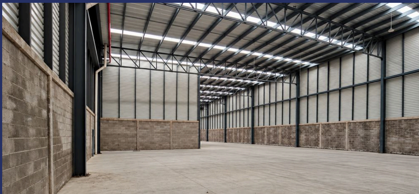
06.2 Interior. Nave libre con estructura metálica, muro de block y lámina.
