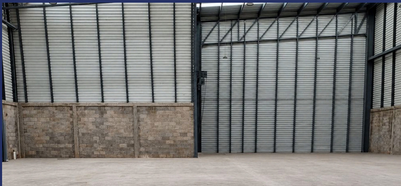
04.2 Interior. Nave libre con estructura metálica, muro de block y lámina.
