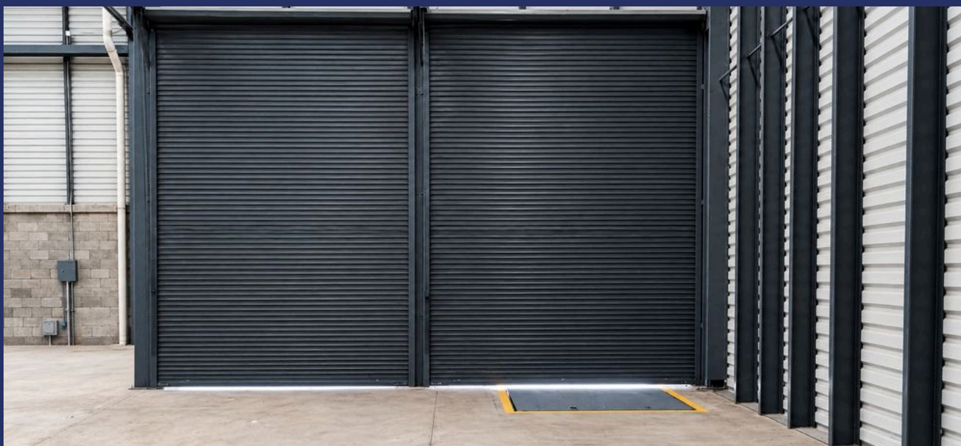
07.2 Interior. Nave libre con estructura metálica, muro de block y lámina.
