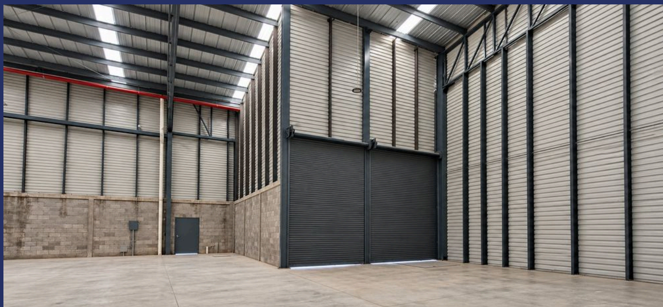
16.2 Interior. Nave libre con estructura metálica, muro de block y lámina.
