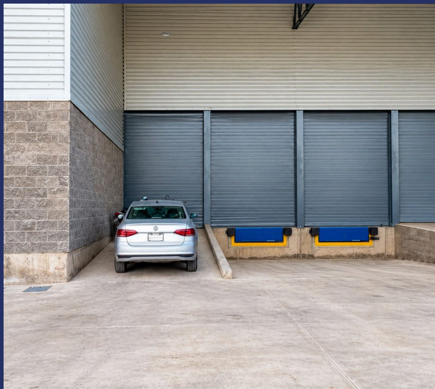
16.1 Exterior. Acceso, andén y patio de maniobras de la bodega.
