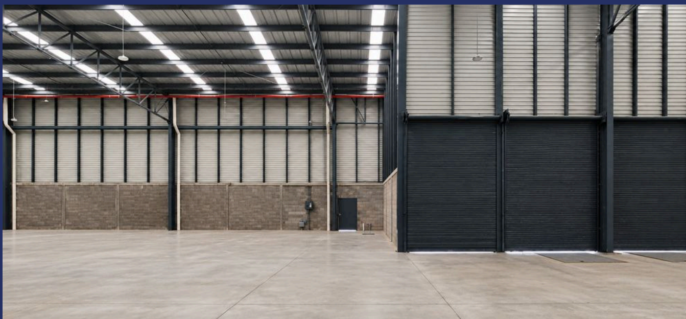
17.2 Interior. Nave libre con estructura metálica, muro de block y lámina.
