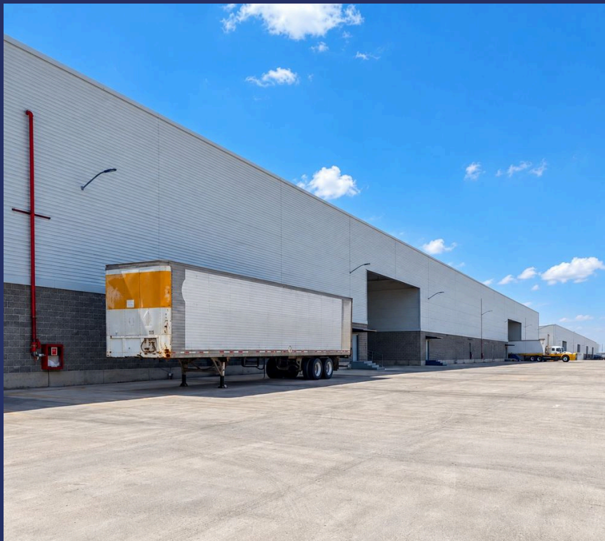
12.1 Exterior. Acceso, andén y patio de maniobras de la bodega.
